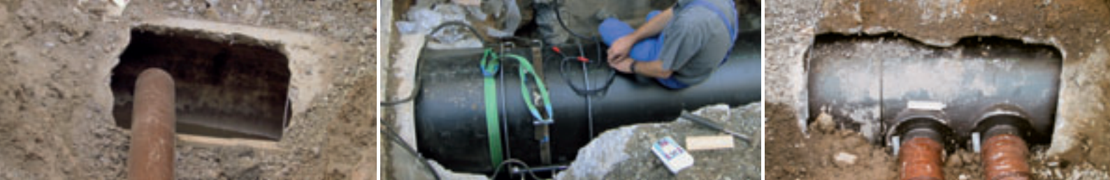
Abb. v.l.n.r.: Aufbruch der Betonrohrleitung im Bereich für die Erstellung der zukünftigen Hausanschlusszuläufe, Verbindung der Rohrmodule mittels Heizwendelschweißung, SIMONA® PE 80 Außensattel SIMOFUSE® verschweißt mit PE 100 Rohrmodul SIMOFUSE® und PVC-KG Rohr mittels Steckmuffenverbindung
