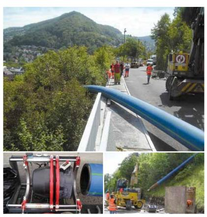
Nachdem das SIMONA® SPC RC Rohr mit dem Zugkopf verschweißt wurde, mußte es eine Distanz von 72 m und eine max. Steigung von 80 % überwinden.
