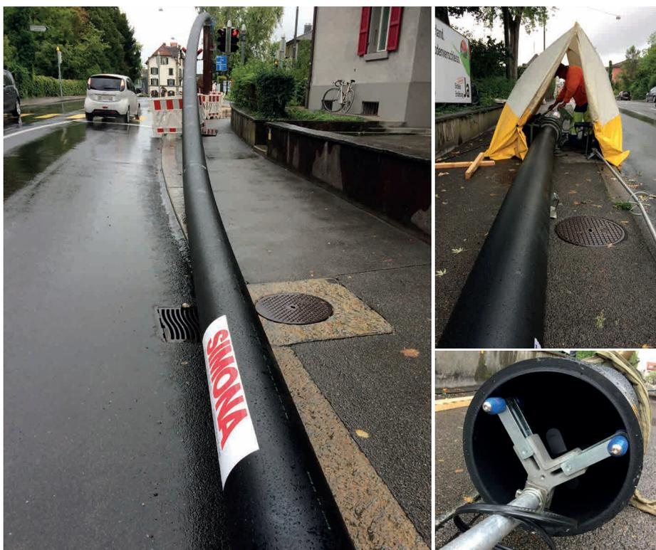
links: der vorgeschweißte SIMONA® PE 100 Liningrohrstrang; oben rechts: Verschweißung (Heizelementstumpfschweißen) der SIMONA® PE 100 Liningrohre; unten rechts: nach dem Schweißen wird sowohl der Innen- wie auch der Außenschweißwulst mit Spezialwerkzeug entfernt
