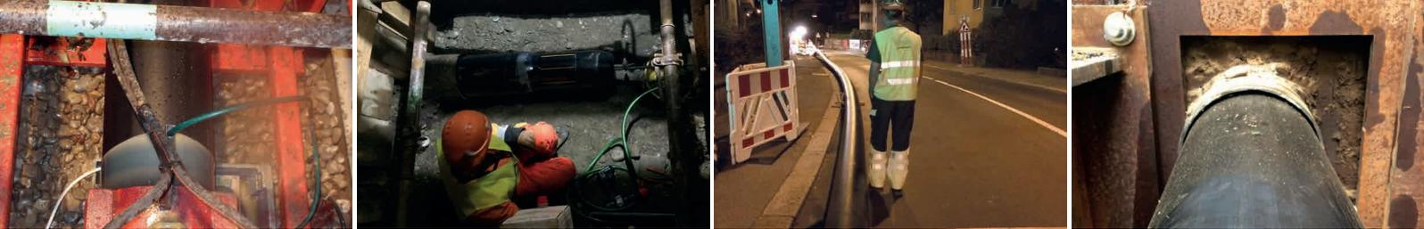
v.l.n.r.: Die SIMONA® PE 100 Liningrohre werden durch das konische Gesenk gezogen und somit im Außendurchmesser reduziert. Während des Rohreinzieges wird sowohl die zulässige Zugkraft als auch die geometrische Veränderung des Rohres stetig überwacht. Nach erfolgtem Rohreinzieg und Ende der Zugwirkung verformt sich das PE Liningrohr in Richtung der Altrinnenwand zurück und legt sich „close-fit“ an (Bild rechts: Zustand nach ca. 5 Stunden; vollständige Rückverformung erfolgt nach ca. 48 Stunden).
