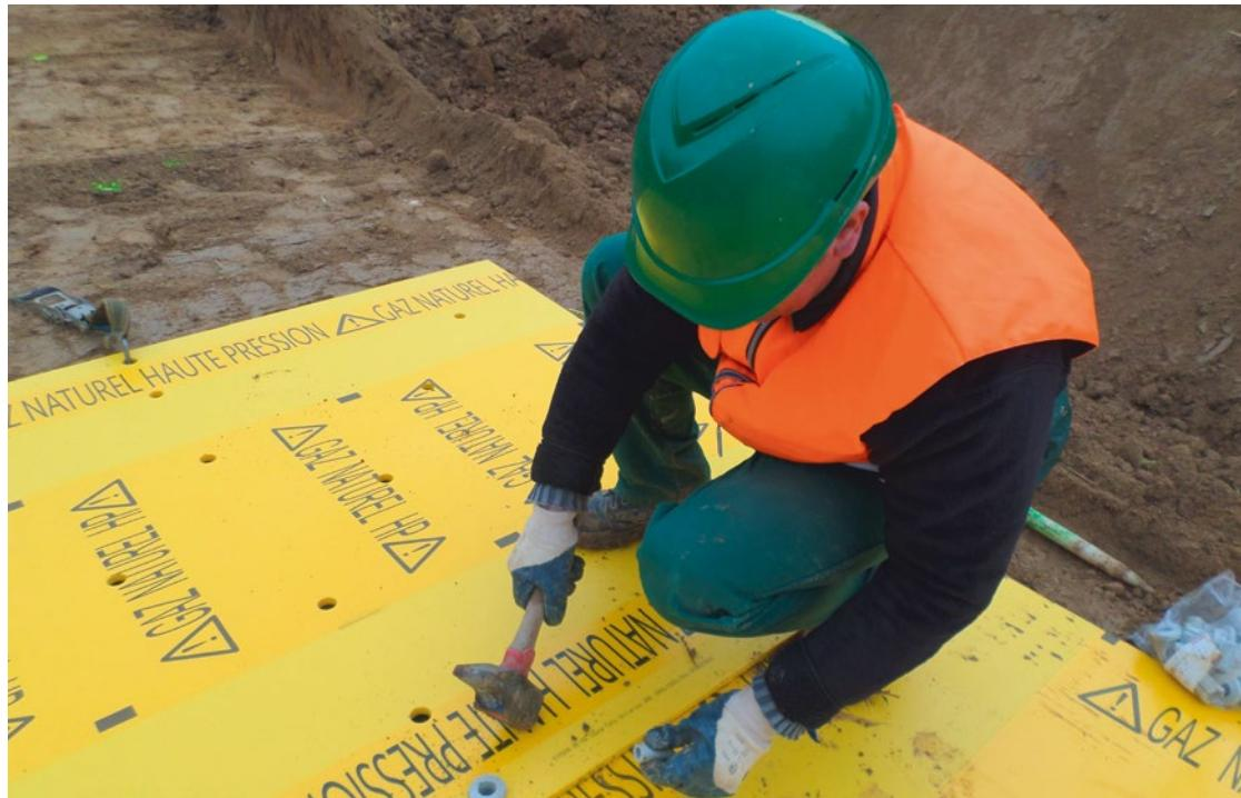
Mit der von SIMONA entwickelten Nieten-Technik lassen sich die Platten schnell und einfach verbinden.
