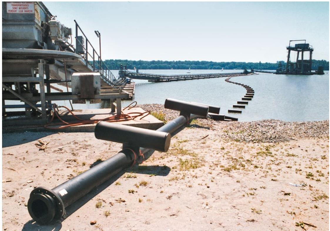
Die Abriebfestigkeit bezeichnet den Widerstand einer festen Oberfläche gegenüber mechanisch-dynamischer Beanspruchung. Diese Form der Beanspruchung findet man im Rohrleitungsbau zum Beispiel dort, wo Flüssigkeiten mit einem relativ hohen Feststoffanteil transportiert werden müssen, wie bei der Förderung von Sand und Kies.
