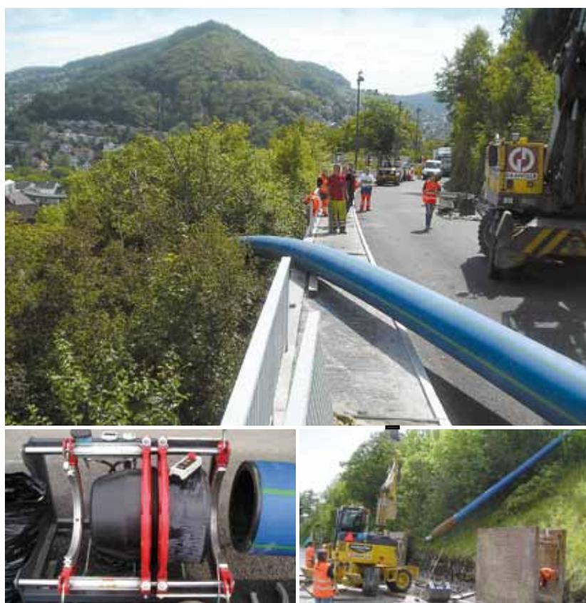
Après le soudage du tube SIMONA® SPC RC avec le tube de forage, il a fallu surmonter une distance de 72 m et un dénivellement maxi. de 80%.
