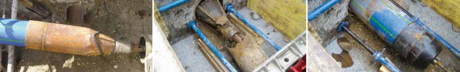
de g. à dr. : la tête d'éclatement est insérée dans l'ancien tube avec le nouveau tube pour eau potable SIMONA® SPC RC-Line ; lors de l'insertion, elle détruit l'ancien tube et le refoule dans le sol ; au final, le tube pour eau potable parvient au puits de sortie.
