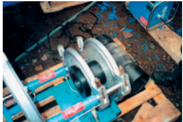
Vorbereitung von Formstücken für die Hausanschlüsse mittels Heizelementstumpfschweißen
