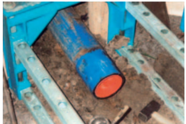
SIMONA® SPC-Schutzmantelrohr im Zielschacht
