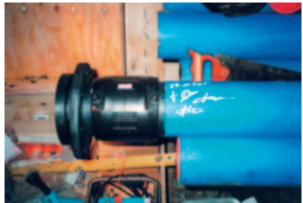
Vorbereitung von Flanschanschlüssen mittels Heizwendelschweißung
