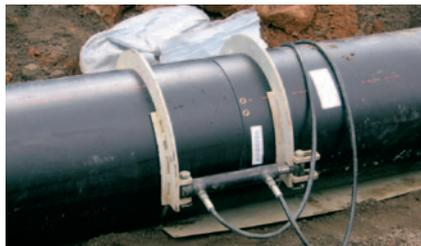
4. Zusammenführung der beiden Rohrenden mittels hydraulischer Kraftübertragung.
